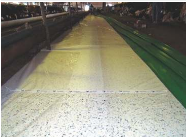
8 обворот матов пленкой и соединение её концов скотчем (что бы пленка не скатывалась внутри) Расход скотча: 2 соединения на 1 мат
