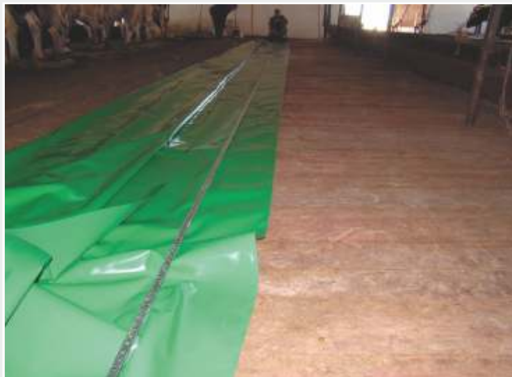
2 Аккуратное просовывание ткани под ленту и выравнивания её от ленты в 2 сантиметра
