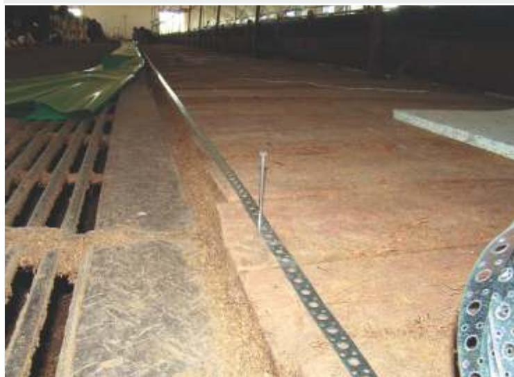
1 Обустройство и небольшой натяг ленты по краю основания. Ленту крепить вначале и в конце
