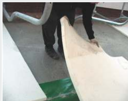
укладка пленки и матов
