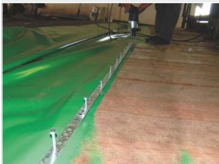
3 установка крепежа и закручивание, (на деревянном основании молотком)
