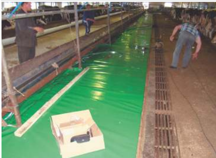
10 натяг ткани и закрепление у изголовья животных
