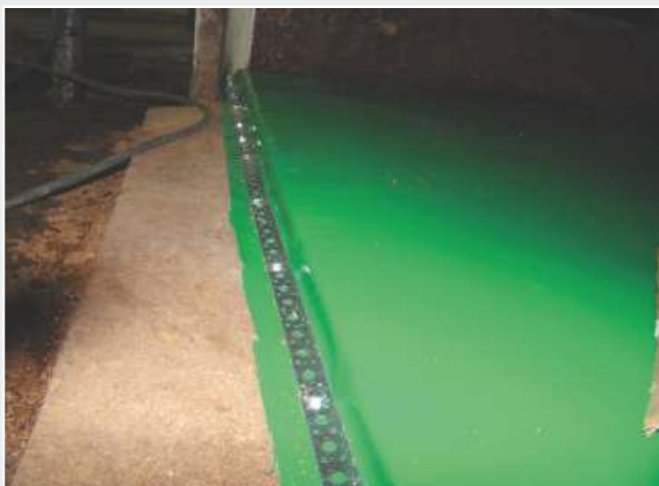
11 натяг и закрепление ткани с торцов
