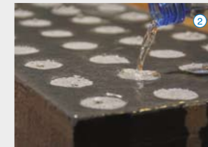
рис. 1. Нанесение «Водного силикона» на бетон через трафарет.
