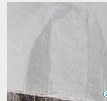
рис. 1. Нанесение «Водного силикона» на участок побеленной стены.
