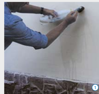
рис. 1. Нанесение «Водного силикона» на участок побеленной стены.
