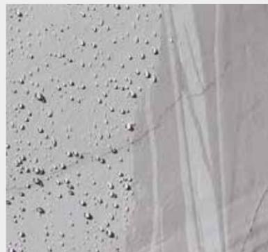
Результат — обработанный участок стены влагонепроницаем.
