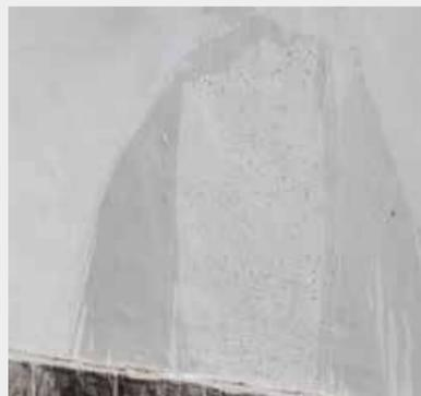
Увлажнение побеленной стены спустя 6 часов после обработки.
