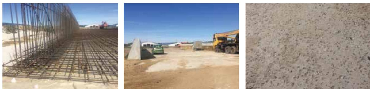
Абсолютно новая силосная яма во Владимирской обл. 2-ярусное армирование, бетон марки М350, толщина заливки 25 см. Все это не спасло дорогостоящую конструкцию от коррозии бетона, вызванной кислотной агрессивной средой. В итоге уже через год на поверхности бетона оголился щебень и идут дальнейшие разрушения.
