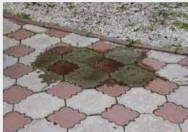
Нанесение «Водного силикона» на участок тротуарной плитки.
