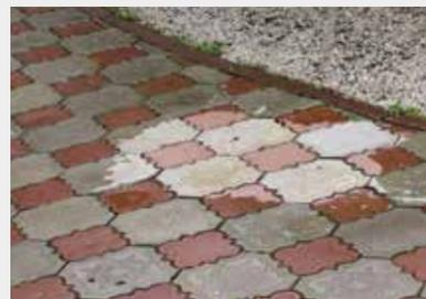
Вид обработанной плитки после дождя.
