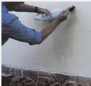
Нанесение «Водного силикона» на участок побеленной стены.
