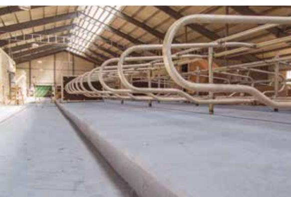
Что касается животноводческой фермы беспривязного содержания общей площадью более 6000 квадратных метров. Высокопрочным бетоном заливалось тут все: кормовой стол, каналы навозоудаления под скрепера, основание лежачков, переходы, аллеи, прочие конструкции. Заливка конструкций тут была снижена с 20–25 см до 10–12 см. Затрачено было на 600 м<sup>3</sup> меньше бетона, чем планировалось.
