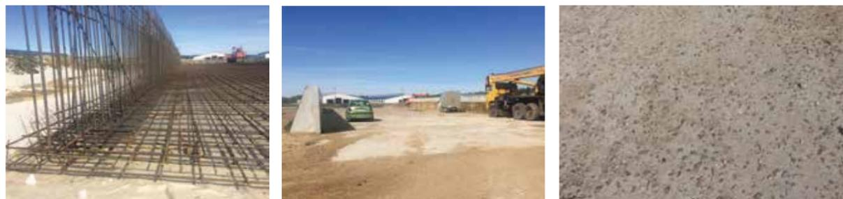
Абсолютно новая силосная яма во Владимирской обл. 2-ярусное армирование, бетон марки М350, толщина заливки 25см. Все это не спасло дорогостоящую конструкцию от коррозии бетона, вызванной кислотной агрессивной среды. В итоге уже через год на поверхности бетона оголился щебень и идут дальнейшие разрушения.
