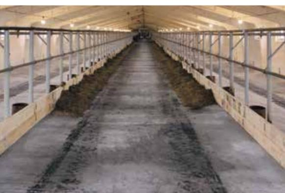
На 6 старых фермах привязного содержания отлили из нового бетона кормовые столы, каналы навозоудаления под транспортеры, центральные проходы, основания лежачков, проходы у стен. Экономия составила 1400 куб.бетона.
